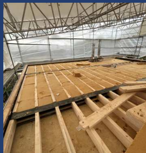
Terrasse en toiture
